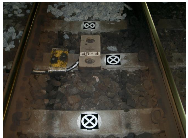
施工後 東京駅構内
