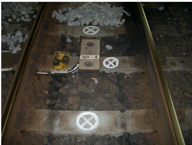
施工前 東京駅構内
